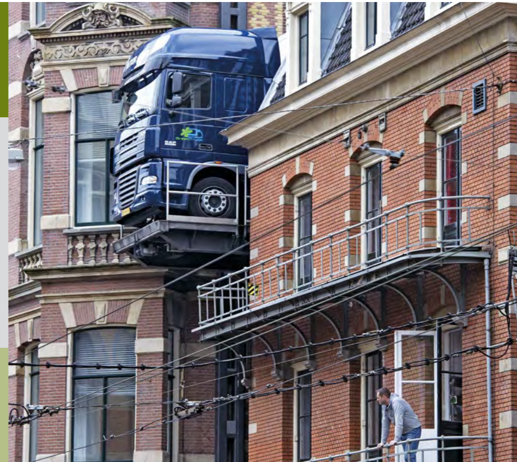
Heavy Class LKW-Hubtisch (LorryLift) (Stadsschouwburg Amsterdam)
